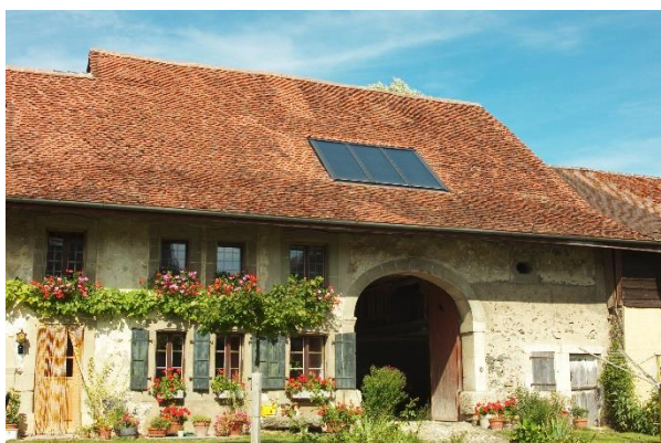
Exemple d'installation solaire thermique (capteur+chauffe-eau) ayant bénéficié de la subvention cantonale (CHF 2000.-) et de l'écobonus communal (CHF 1200.-).
